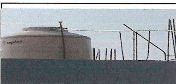
Foto 10: Implementación de sistema de agua de 5000 mil litros, bomba sumergible de 2 caballos de presión y tubería pvc
