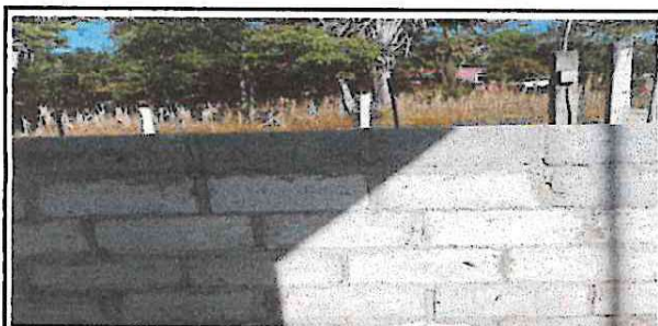
Foto 9: Reparación de muro perimetral de block hg y malla galvanizada
