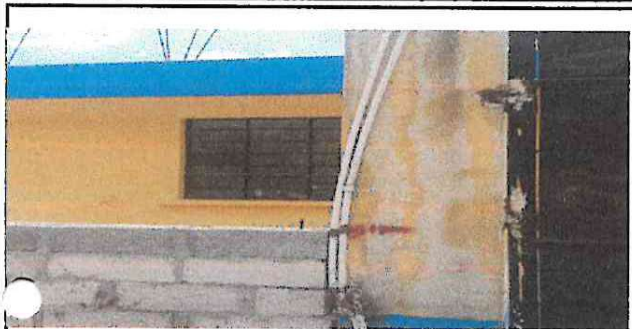
Foto 13: Sustitucion de tubos de pvc o metal para bajada de agua pluvial
