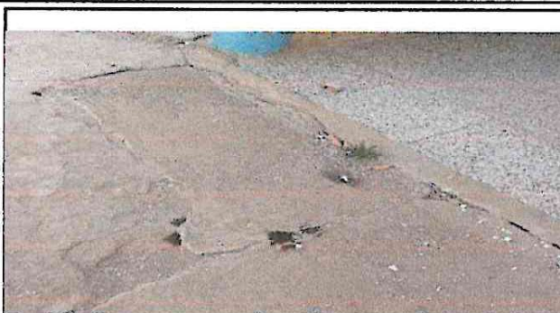
Foto 8: Reparación de torta de concreto
